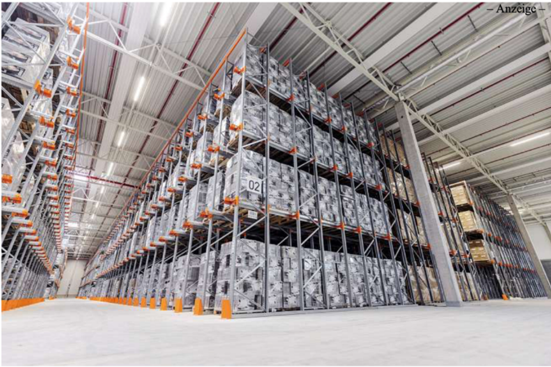
Zwei der Hallen mit insgesamt 20.000 m² sind aufwendig auch zur Lagerung von Gefahrstoffen wie Batterien oder Chemikalien ausgelegt. Mit 3 verschiedenen Regalsystemen ausgestattet, können insgesamt 50.000 Paletten eingelagert werden.
