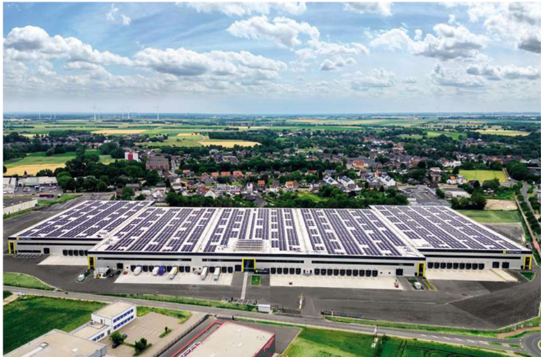
Die 50.000 m² Dachfläche wird vollständig für Photovoltaik und Solarthermie genutzt und ist damit eine der größten gebäudegebundenen Anlagen in NRW. Der Bau entspricht dem Energieeffizienzlevel 40 Plus. Also dem Wert eines Niedrigenergiehauses.
